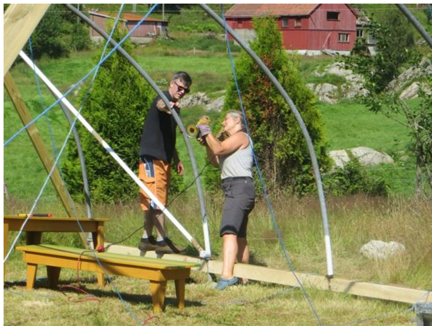
Figura 17: Construção de Green House , Noruega Fonte: Arquivo da autora
